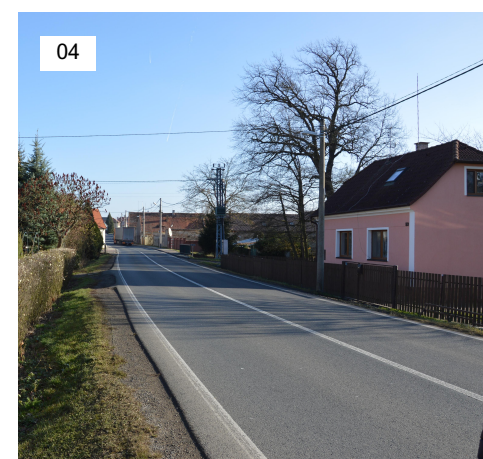
Hlavní silnice Rušná hlavní silnice má negativní vliv na celkové fungování obce. U západního a východního konce obce chybí chodníky.
