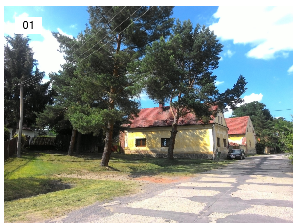
Příjezdová cesta Příjezdová cesta slouží jako obslužná komunikace pro několik stávajících domů. U křižovatky je cesta asfaltová, dále pokračuje jako panelová.
