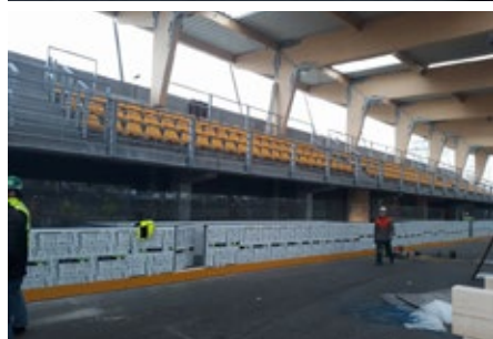
Práce na sportovní hale pokračují. Montáž mantinelů proběhla bez problémů.
